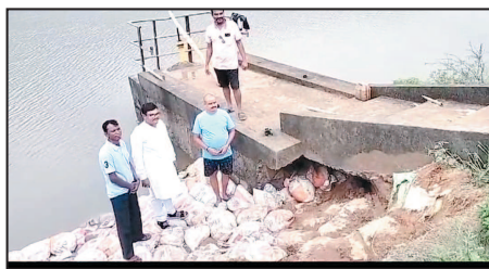
गया जहां से लगातार बड़ी मात्रा में पानी बांध से निकलना चालू हो
